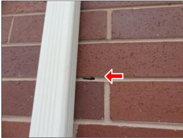
A. Picture 14 Mortar Gap
