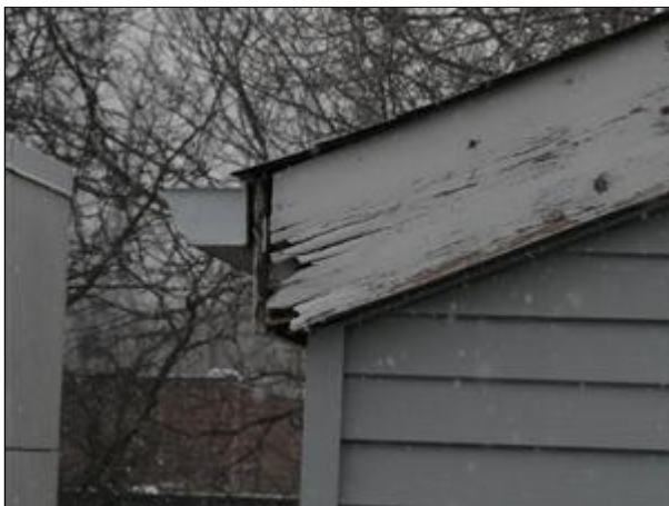
A. Picture 7 replace rake fascia
