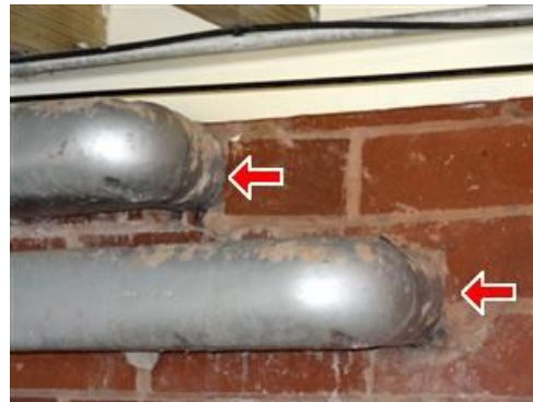
A. Picture 10 Feeder Conduit
